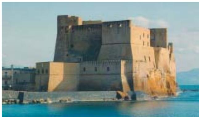
Figura 4. Un ejemplo del uso de los tufos zeolíticos para la construcción de edificios. El Castel dell'Ovo, en Nápoles, fue edificado en el siglo XII con tufo amarillo napolitano.
