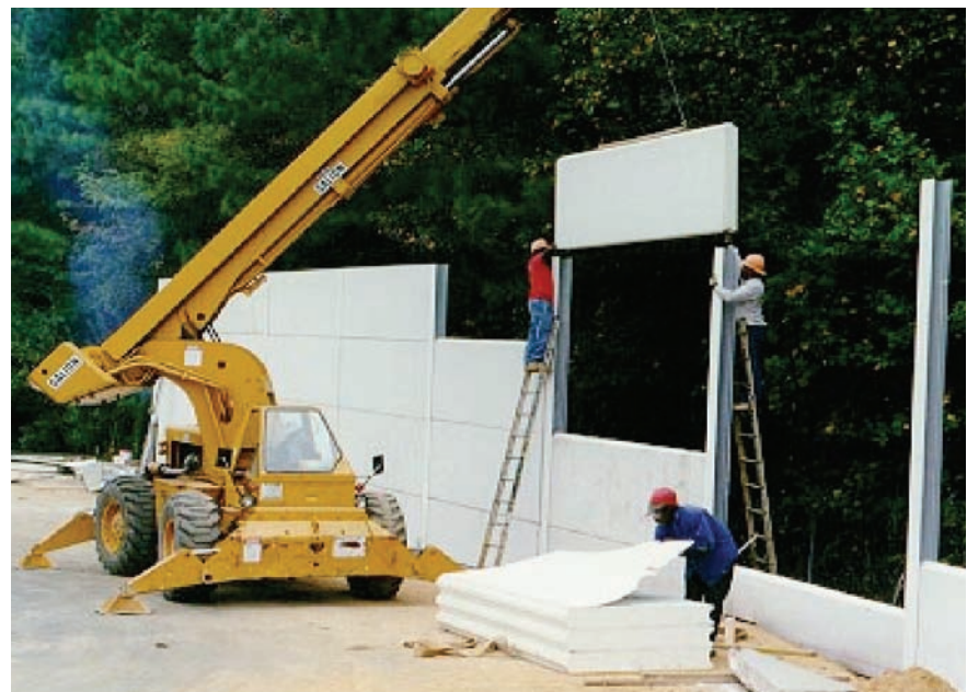
Figura 2. Placas de concreto ligero aireado, un nuevo material fabricado con matriz de cemento Portland y dispersoide o agregado de arena y polvo de aluminio como agente aireador. El agente aireador es el agregado o aditivo que se incorpora a la mezcla de cemento y arena para introducir miles de burbujas de aire dentro del compuesto en el momento de secar y fraguar, lo cual hace que el material sea más ligero.
