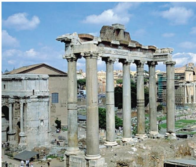
Figura 5. Templo de Saturno, cuyo basamento está construido con cantera; sobre él descansan las columnas de granito egipcio.
