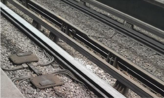
Figura 1. Balasto sobre las vías en una estación del tren subterráneo en Ciudad de México
