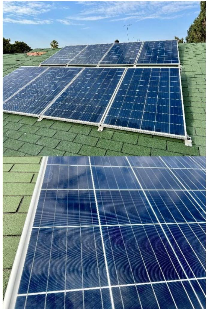
Figura 1. En la parte superior, un arreglo de ocho paneles solares de 250 W cada uno. En la parte inferior, un acercamiento a las celdas que componen el panel.
